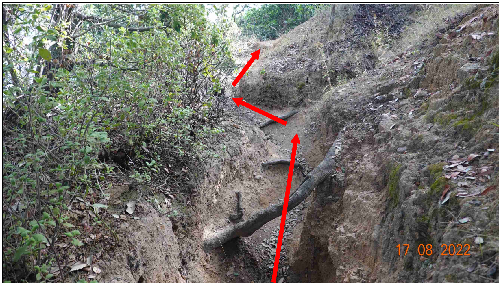
Figure 21 : Poursuite du chemin sur la parcelle I 1510 nécessitant l'instauration d'une modification de servitude. Elle est régulièrement empruntée par les randonneurs et bien tracée. Un aménagement léger pourra être effectué pour sécuriser le sentier.
