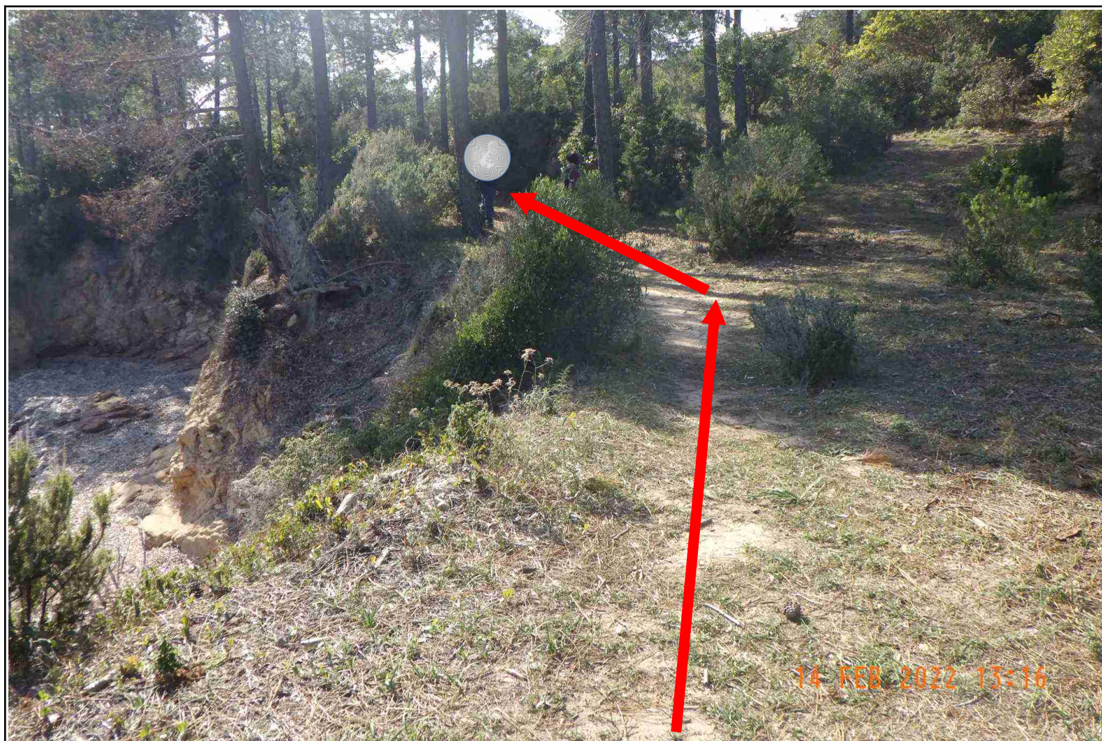
Figure 40 : Vue du chemin usuel passant le long de la mer, nécessitant la modification de la servitude de droit. La servitude de droit ne peut pas être mise en œuvre en cet endroit à cause du relief de la côte.
