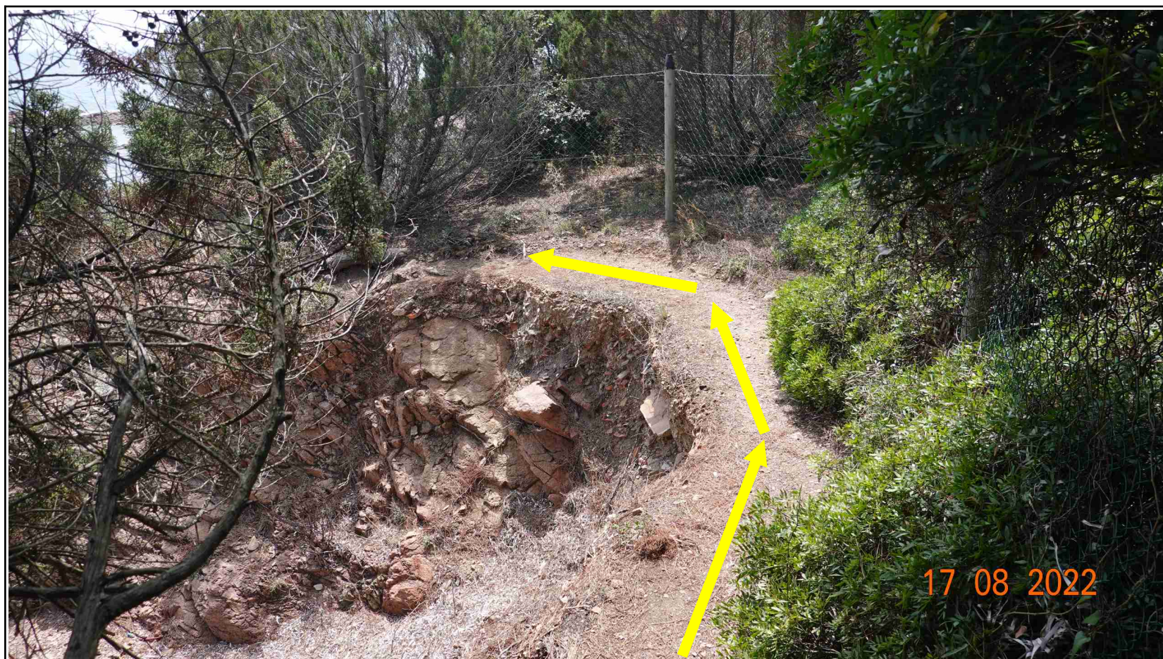
Figure 55 : Au point GPS 1232455,02E – 6084435.16N le sentier usuel se trouve sur la servitude de droit. La servitude de droit longe le grillage délimitant la propriété. La largeur du sentier existant est actuellement inférieure à trois mètres, le grillage devra être utilement reculé afin d'atteindre la largeur de 3 mètres.
